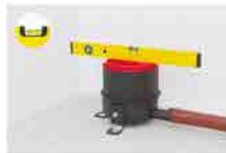
6. Priključiti telo slivnika na odvodnu instalaciju i podesiti nagib cevi.
