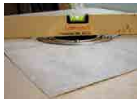
6. Hidroizolaciona garnitura je ispod nivoa košuljice
