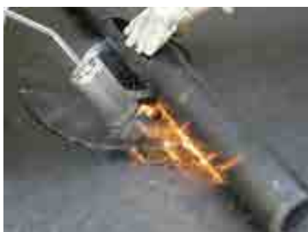
4. Zavariti drugi bitumenski sloj na kragnu slivnika
