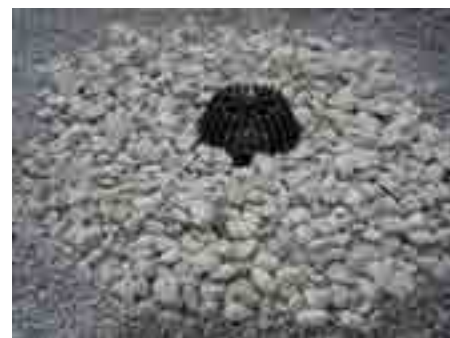
12. Ostatak površine ispuniti sljункom
