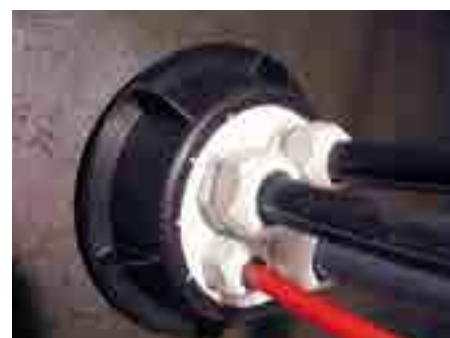
6. Cevni prolaz je postavljen!
